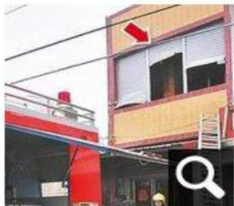
林女疑打不開二樓鐵窗 (箭頭處)，吸入過多
