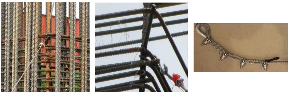
圖2：斜拉鋼索以鋼索夾與墩柱鋼筋結構固定
