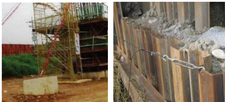
圖3：斜拉鋼索與支持物固定
